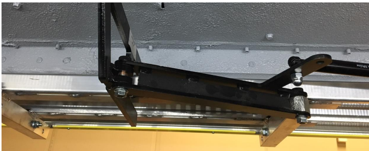
Bild 5. Mellersta konsolen med gasdämpare monterad
